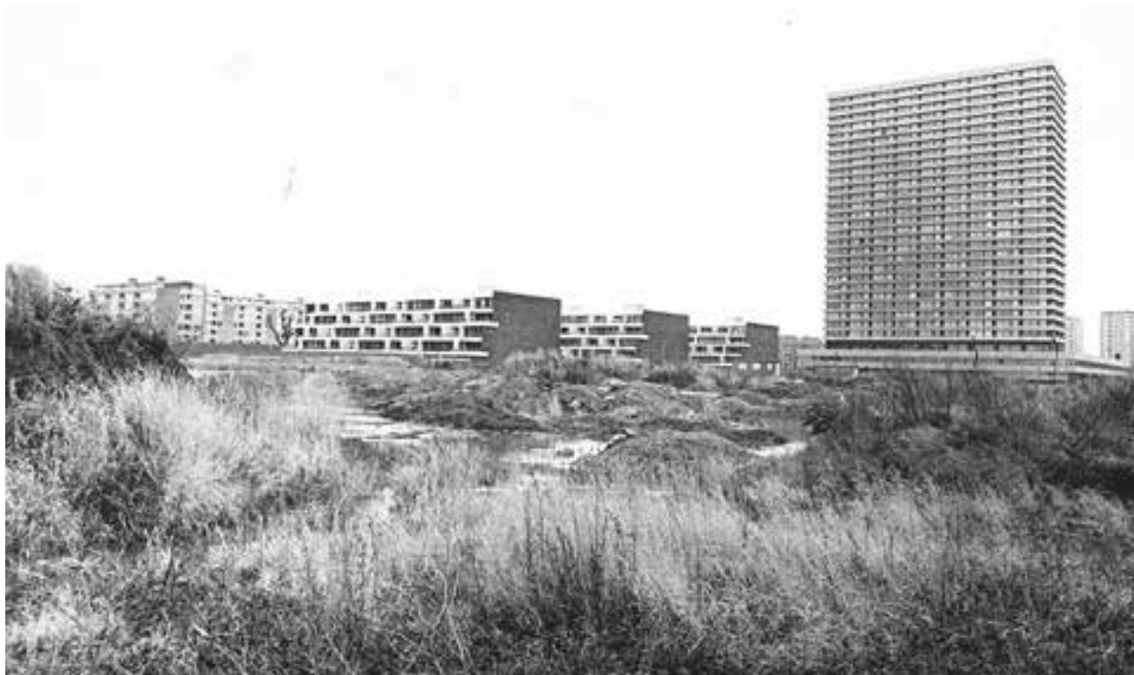
I 1975 etablerede OK-Fonden et plejehjem i de to nederste etager i højhuset Domus Vista.
